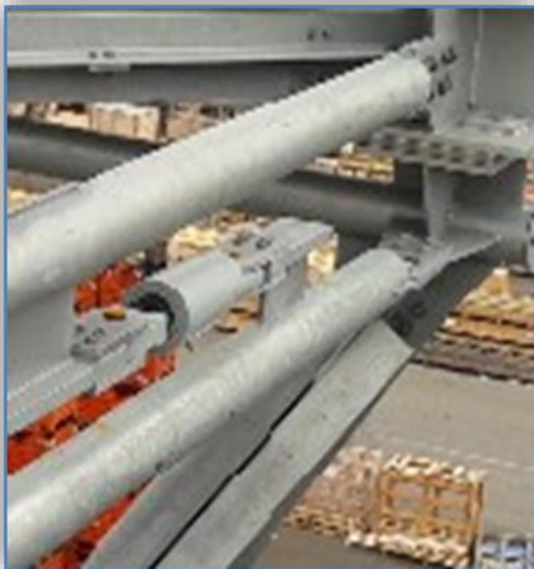
- Adeguamento sismico Sito Industriale Modena - Shock Trasmitter -
