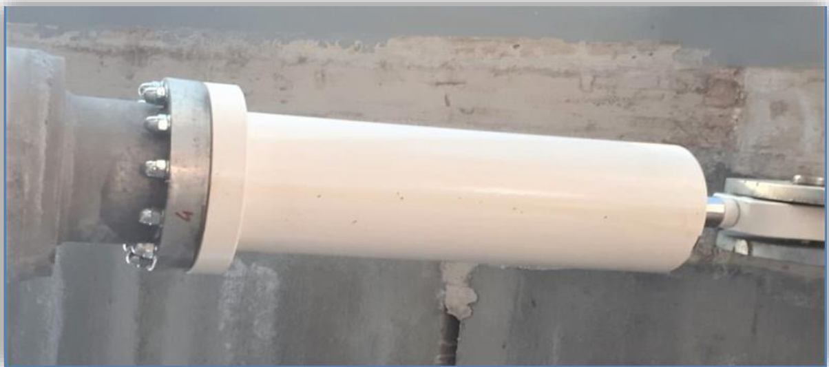
- Nuova sede CPC srl di Modena -dissipatori oliodinamici tipo Fluid Viscous Damper -
