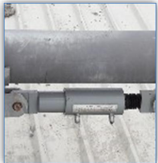
- Adeguamento sismico Sito Industriale Modena - Shock Trasmitter -
