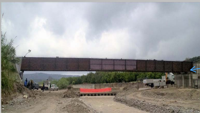
Ponte Metallico Catanzaro
