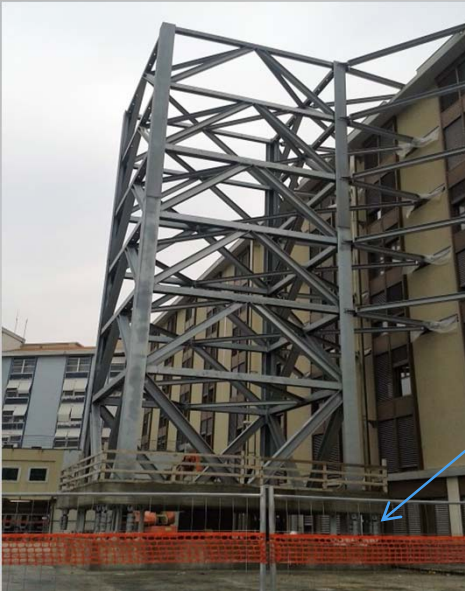
Ospedale Riuniti Torrette Ancona
