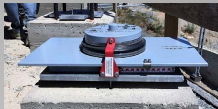
Appoggio Sferico Multidirezionale CE-RFI
