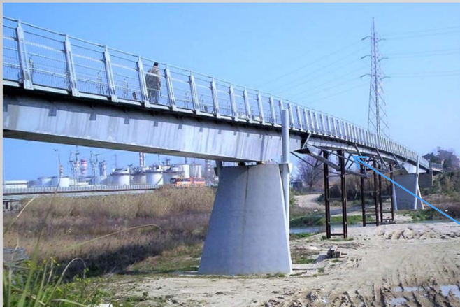
Passerella Pedonale Ancona
