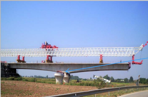
Viadotto a conci Autostrade Venete
