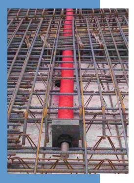
Per assolvere alle funzioni di coprigiunto filo soletta, la Tec realizza varie soluzioni capaci di assorbire la variazione dell'ampiezza del varco strutturale dal valore minimo di +/- 10 mm fino al valore di +/- 20 mm presentando le versioni dei giunti serie Tec GS; Tec AS; Tec PS.
